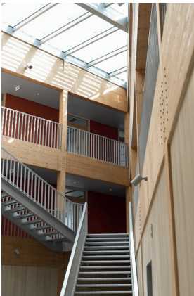
Structure en bois de l'Infrapôle de Versailles-Chantiers. © AREP - photographie 16Prod, 2026
