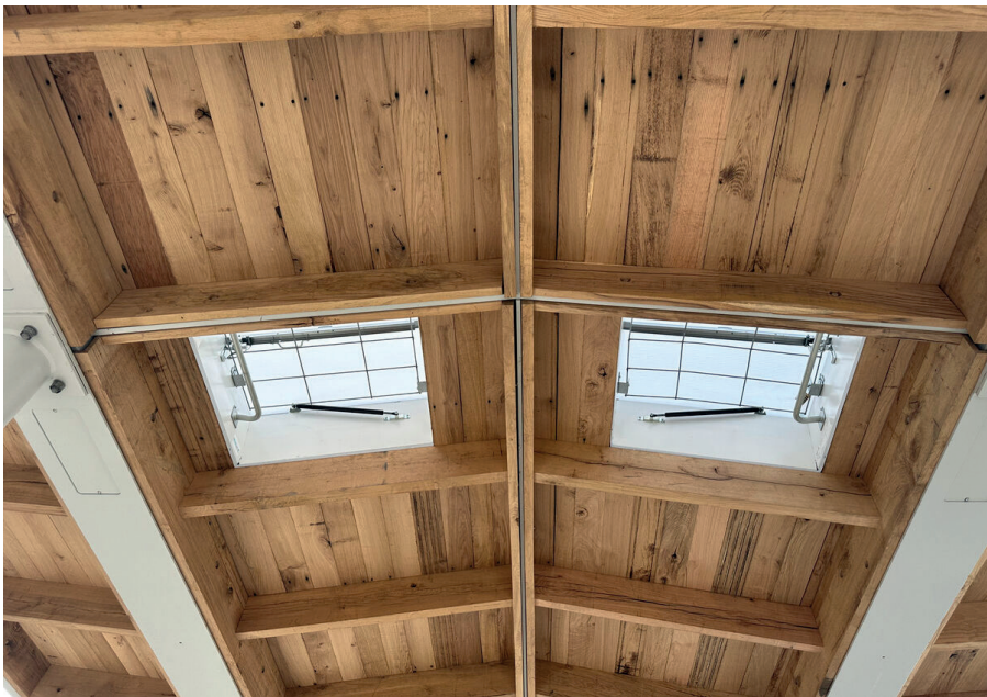
Le réemploi des rebuts de traverses de chemin de fer pour l'abri filant de la gare de Melun. © AREP, 2025
