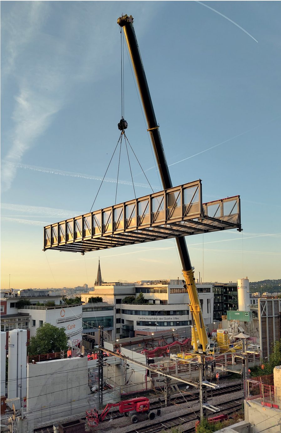
Chantier de la passerelle d'interconnexion SGP / SNCF de la gare de Saint-Cloud. © AREP - photographie Benoît Quagliozzi, 2026
