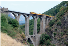
Le pont Séjourné et le train jaune. Le chemin de fer de Cerdagne a été inscrit sur les listes indicatives de l'UNESCO. © AREP - photographie Perrine Dubreux, 2022
