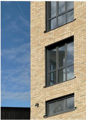
Façade en brique de l'Infrapôle de Versailles-Chantiers. © AREP - photographie Giacomo Bongiorno, 2026
