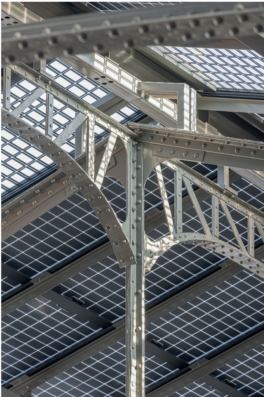
La halle en chantier de la gare d'Angoulême - Panneaux photovoltaïques © AREP - photographie Guillaume Satre, 2025
