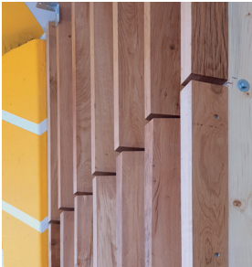
Prototype de mise en œuvre du bardage du projet Paris-Lyon côté Seine. © AREP, 2024
