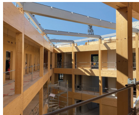
Bâtiment de relogement des bureaux SNCF « Infrapôle » de Versailles-Chantiers. © AREP, 2025
