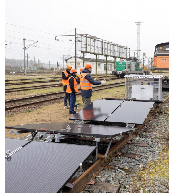
Installation du prototype sur site. © SNCF/AREP - photographie Yann Audic, janvier 2025
