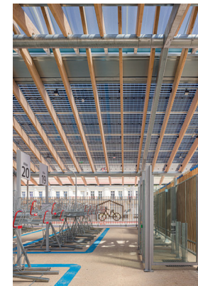
Gare de Paris Nord – La halle à vélos solaire, intérieur. © AREP - photographie Guillaume Satre, juin 2024
