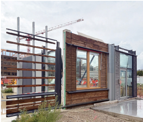
Chantier des Grandes Serres de Pantin – Prototype de façade. © AREP, septembre 2025
