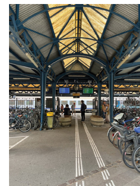
Gare de Colmar – Abri vélos. © AREP, juillet 2024
