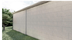
Modélisation du prototype de réemploi de voiles béton sciés.
