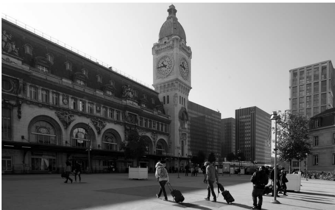
Parvis monumental de la gare de Lyon et tour de l'Horloge
