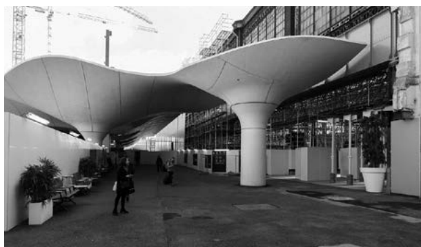
La nouvelle marquise en béton blanc de la gare
