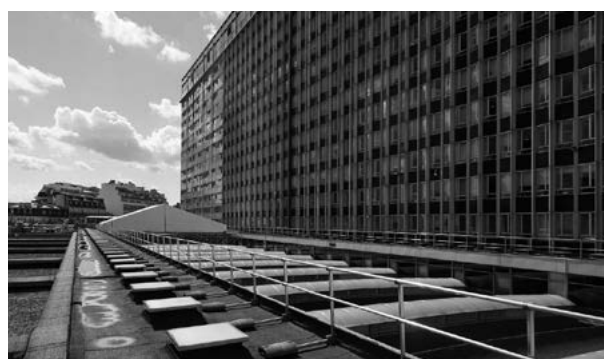
D'importantes surfaces de toiture plates
