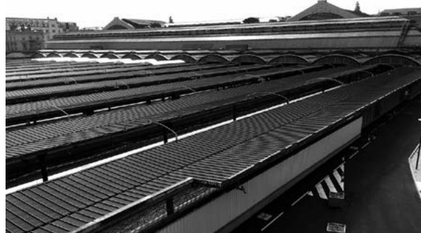
Linéaires d'abris de quais
