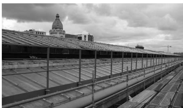
Une large toiture en zinc pour la halle voyageurs
