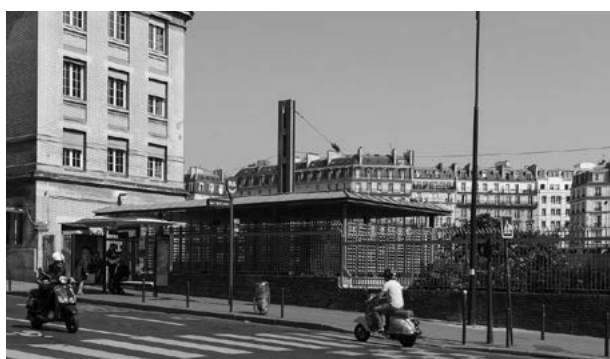
Entrée rue de Rome
