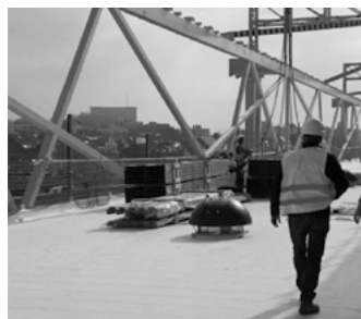
Exemple d'application d'une membrane réfléchissante 1 .
