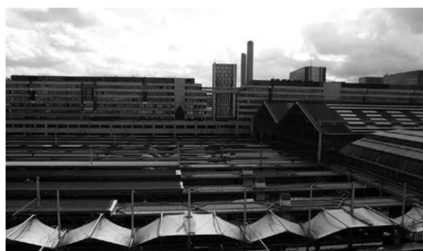
Linéaires d'abris de quais
