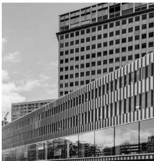
Gare Montparnasse, la façade rénovée, 2020
