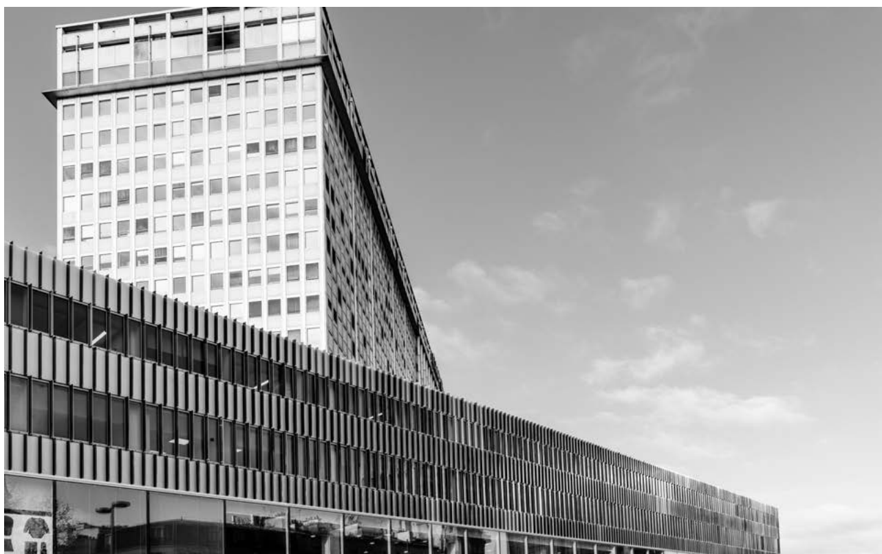
Gare Montparnasse – la façade rénovée – décembre 2020
