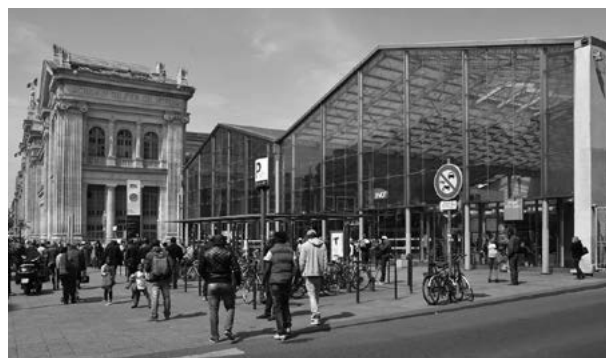
Angle sud-est de la façade et son parvis minéral
