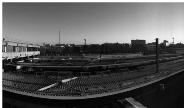
Auvents en bacs acier et quais en asphalte
