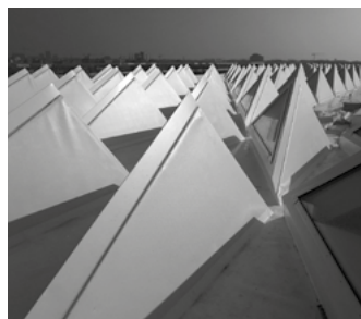
Exemple d'application d'une membrane réfléchissante 2 .
