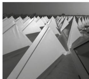
Exemple d'application d'une membrane réfléchissante<sup>2</sup>.
