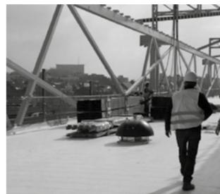
Exemple d'application d'une membrane réfléchissante<sup>1</sup>.
