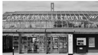
Ci-dessous, toit solaire de la gare de Stains-La Cerisaie, Île-de-France.
