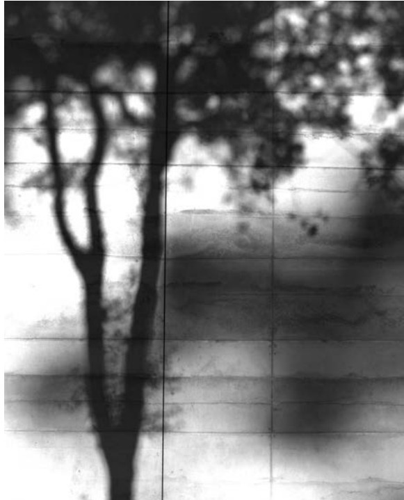
Mur en béton de terre, gare de Nîmes Pont-du-Gard TGV.
