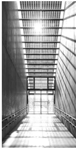
Ci-contre, accès piéton sous le filtre des panneaux photovoltaïques, gare de Besançon Franche-Comté TGV.
