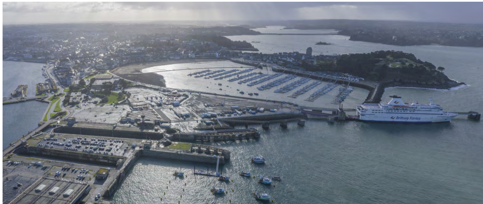
Vue de l'existant
